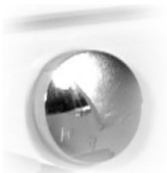
Zum Öffnen oder Schließen der Abflusseinrichtung drehen Sie den verchromten Überlauf in die jeweilige Richtung. Sollte der Wanneneinlauf betätigt sein, ist es empfehlenswert, den Abfluss zu schließen und kein Wasser auszulassen.
